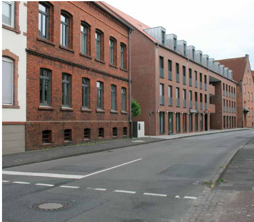
Abbildung: Sich einfügende neue Architektur, aber Aufwertungsbedürftiger Straßenraum entlang des Ostwalls
